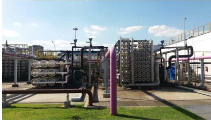
Abbildung 19: System der Umkehr Osmose
